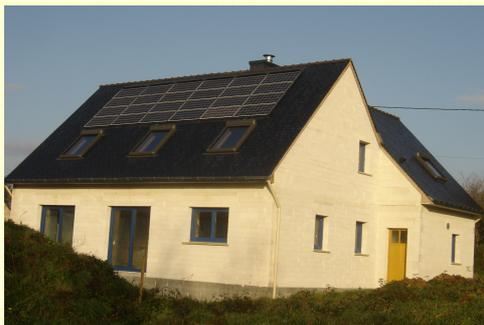
assistance technique pendant toute la durée du chantier. Les premiers coups de pioche ont été donnés le 28 janvier 2009. J'ai démarré l'élévation des murs en blocs de béton cellulaire de 50 cm d'épaisseur le 24 mars.
