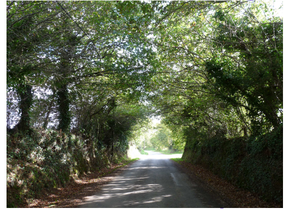
Exemple d'une voie qui nécessite un élagage.
